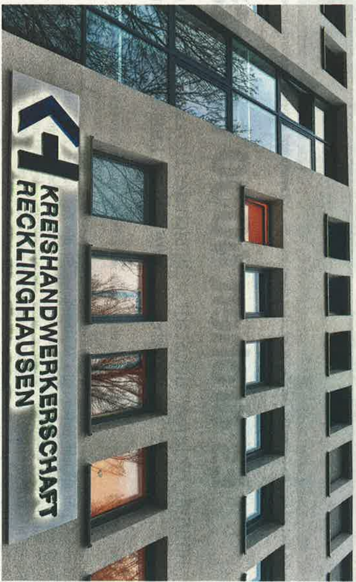
Neue Fassade und Fenster: Die energetische Sanierung der Kreishandwerkerschaft ist abgeschlossen.
